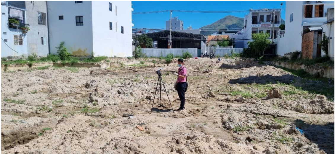
Hình 3.1. Hiện trạng khu đất thực hiện Dự án
